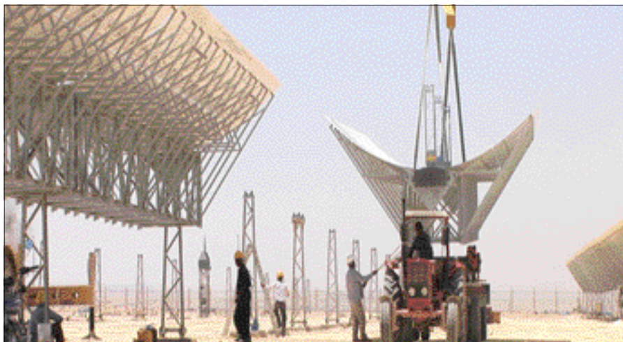
Construction d'une centrale solaire thermique en Egypte, financée par le FEM
